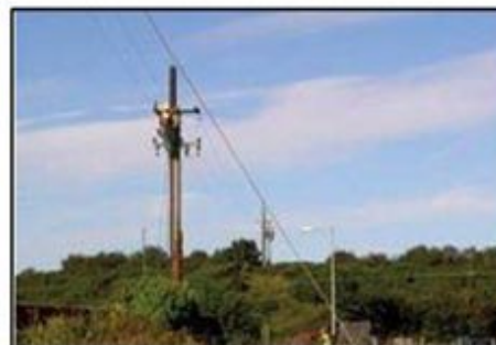
Energetyczna linia przesyłowa na podporach drewnianych
