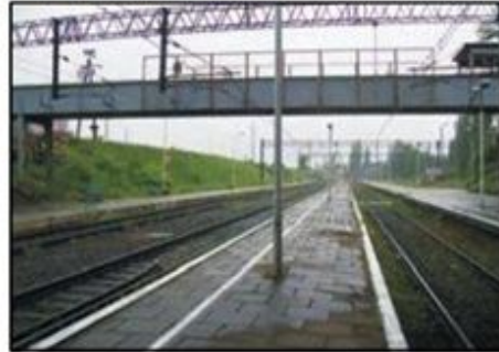
Linia kolejowa normalnotorowa zelektryfikowana – trzytorowa
